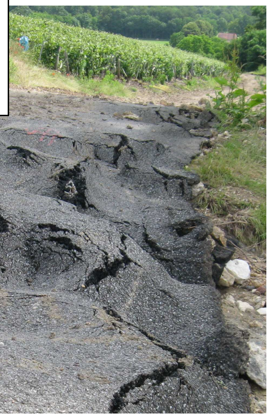
Sur le coteau viticole, même sur les coteaux peu pentus, les matériaux ont été arrachés, et parfois déposés un peu plus bas, comme sur ces clichés, ou entraînés vers le Dolloir – ci-contre le long du chemin du CSA, ci-dessous le chemin dit des Justices
