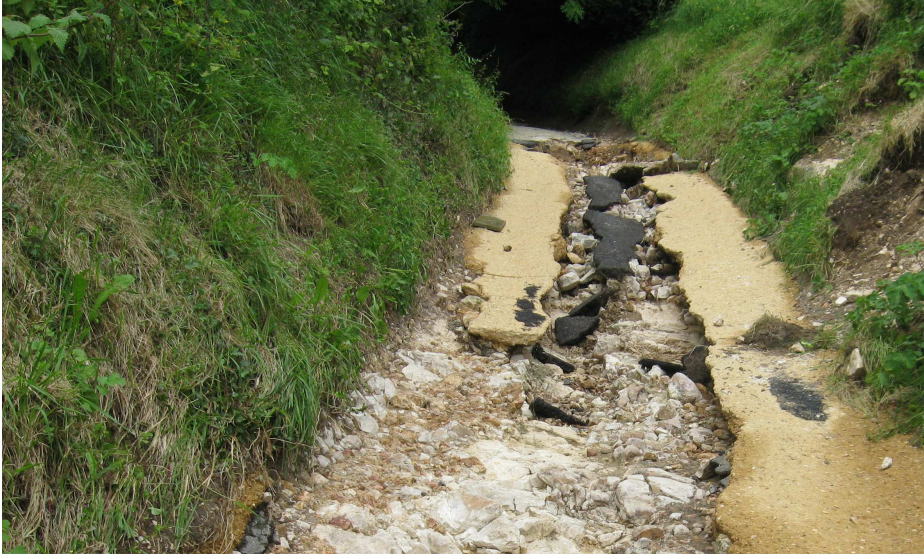
Les chemins existants, exutoires naturels des ruissellements des coteaux, se sont transformés en torrents. Ci-contre le chemin rural dit de la rue des Berges (H2), ci-dessous le chemin de la Croix Gerbeaux (H7)
