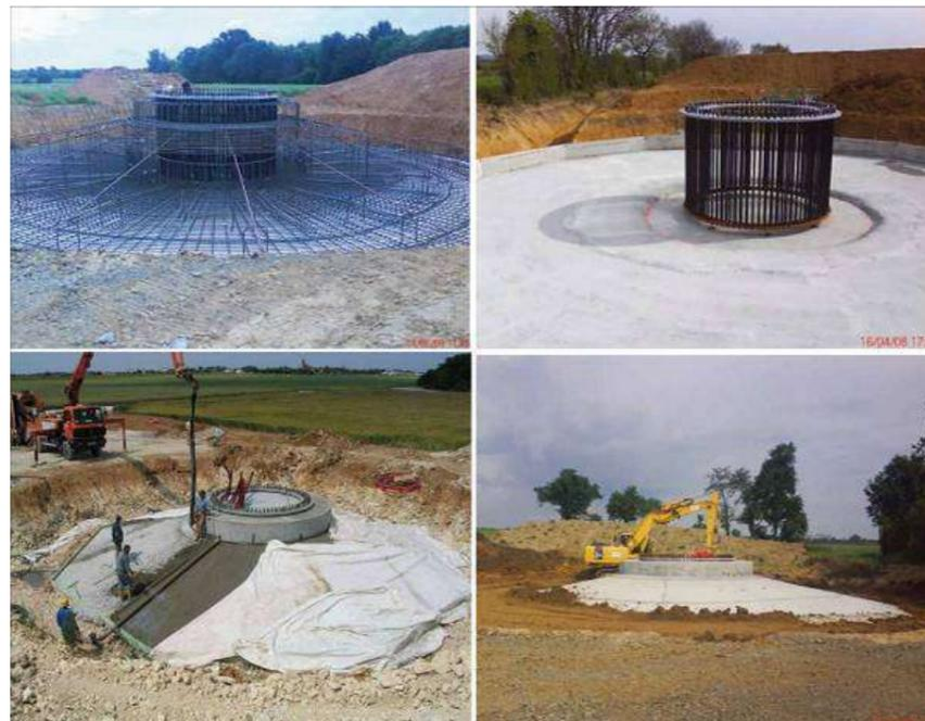
Photographie 13. Etapes de la construction d'une fondation
