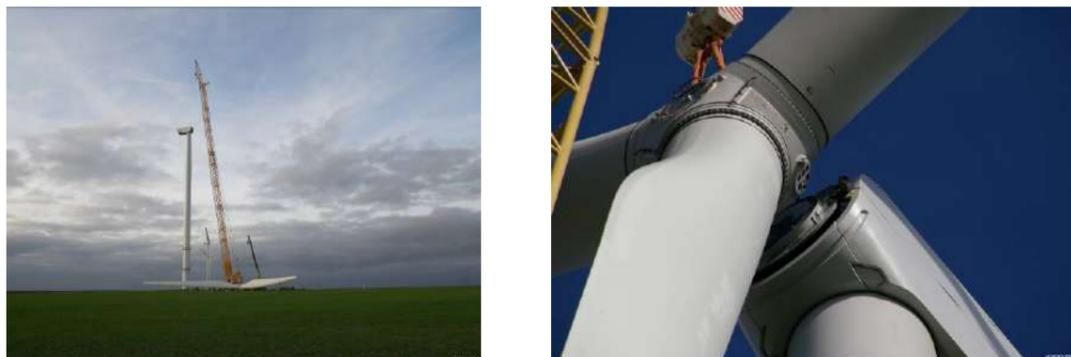
Photographie 15. Montage d'une éolienne
