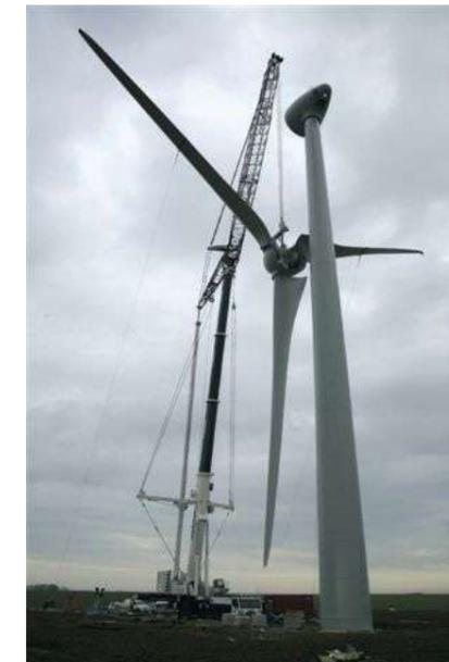
Photographie 3. Assemblage d'une éolienne
