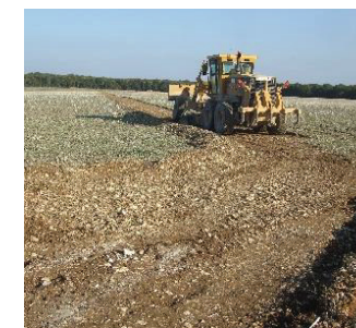
Décapage pour câblage
