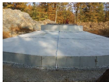
Massif d'éolienne avec ceinture équipotentielle pour MALT
