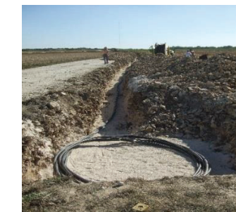
Pose de réseaux HTA
