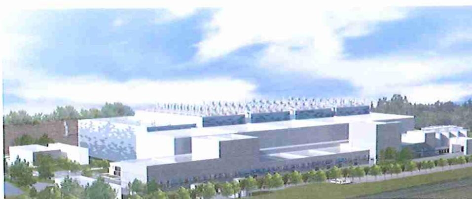
Le projet aura une surface de plancher supérieure à 5 ha, mesurera plus de 35 mètres de hauteur à l'acrotère, et comportera des façades en bardage métallique et une toiture comportant de nombreux lanternaux de désenfumage.
