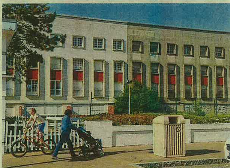
La résidence Les Cygnes est une verrue à l'entrée de Quend. Le rachat à l'amiable des appartements dure depuis des années.
