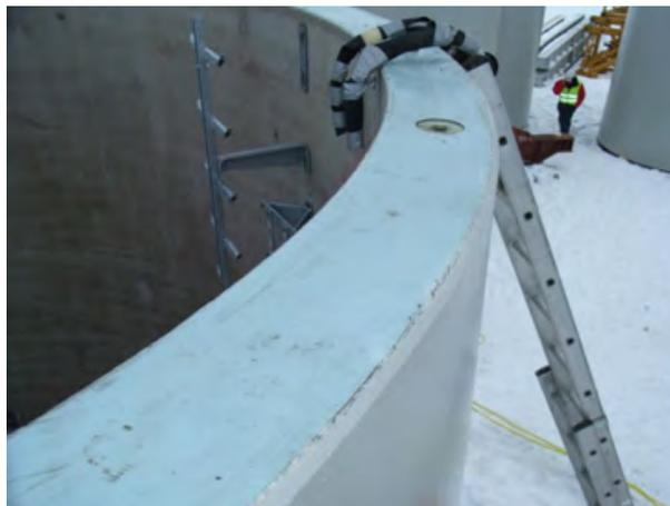
Figure 4: Le joint horizontal est aplanie avec de la résine époxy et les sections sont placées les unes au-dessus des autres sans être collées
