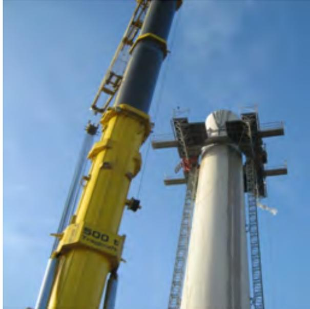
Figure 9: Plateforme de montage extérieure
