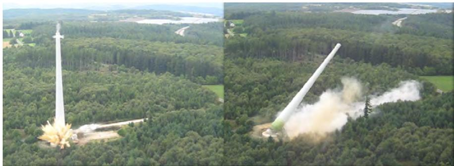
Figure 6: Dynamitage du mât en béton d'une éolienne
