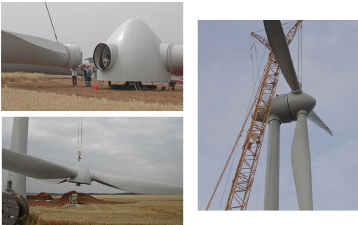
Figure 7 : Assemblage et montage d'un rotor ENERCON
