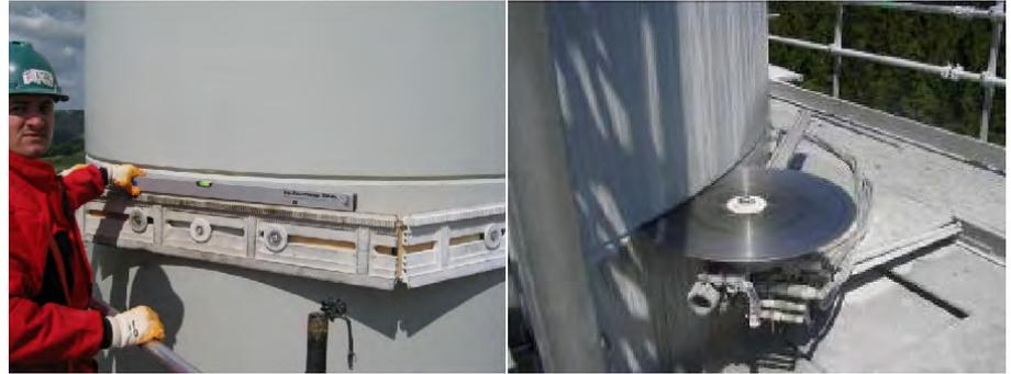
Figure 10: à gauche : Préparatifs pour la scie murale (paroi du mât), visser le rail de guidage sur la section / à droite : Commande hydraulique de la scie par une commande à distance
