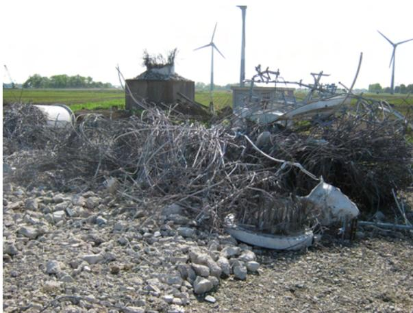
Figure 17: Armature en béton et en acier séparée
