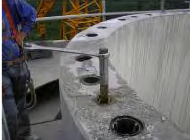
Figure 12: Repassage de filetages endommagés
