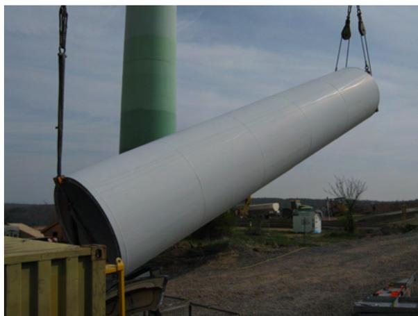
Figure 16: Déposer la section du mât
