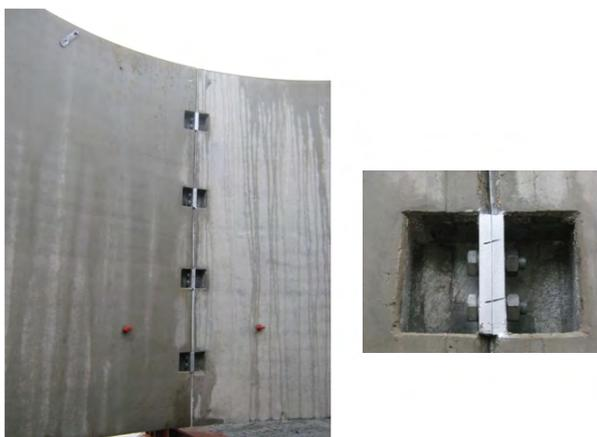
Figure 2: Le joint vertical est formé à l'aide d'un jeu de vis
