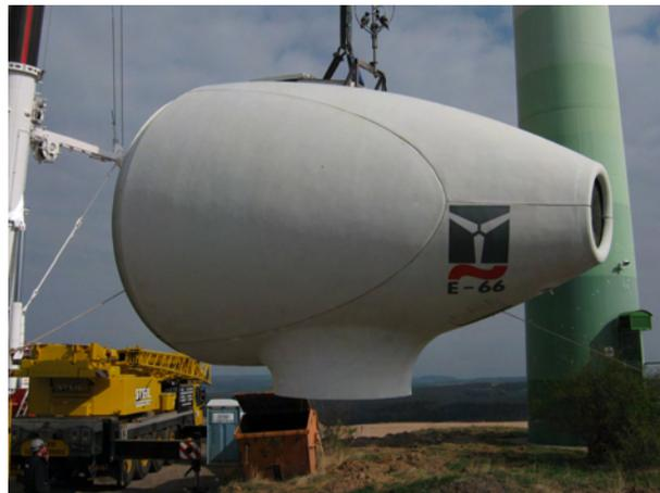
Figure 1: Retirer la salle des machines
