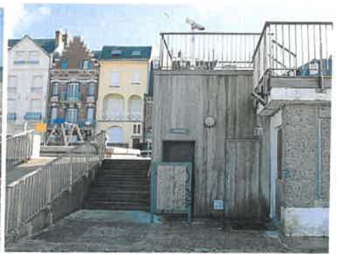
B6 divers WC BAS POSTE DE SECOURS
