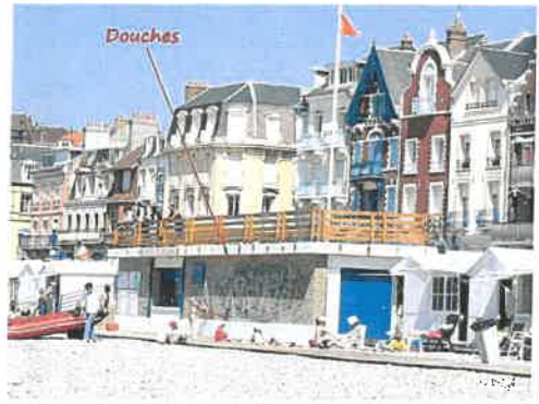
B4 divers DOUCHES POSTE SECOURS été
