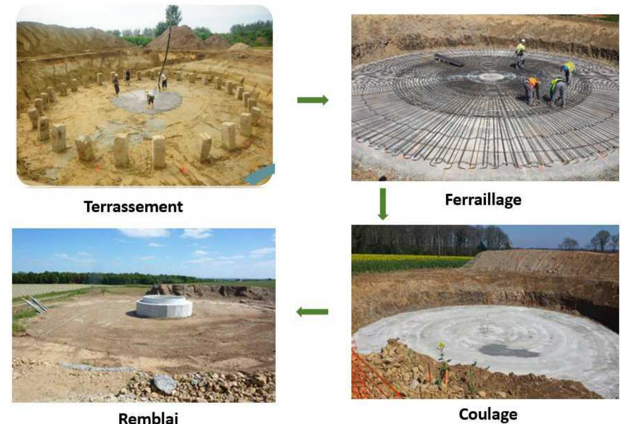
Figure 3. Construction des fondations. Source : ELICIO.
