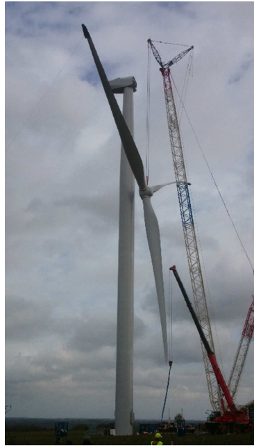
Figure 4 et 5. Montage des pales d'une éolienne (à gauche) et acheminement d'une pale (à droite). Parc éolien de Sévérac-Guenrouët. Source : ELICIO.
