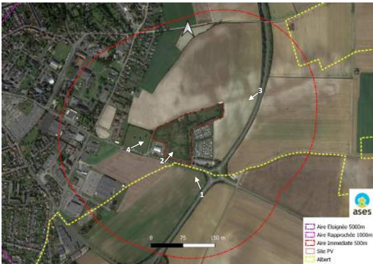
Figure 12 : Localisation des prises de vues.
