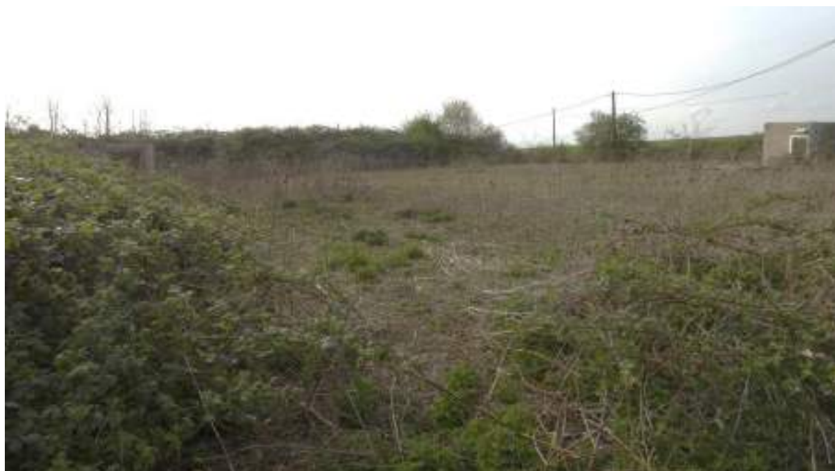
Figure 27 : Photographie n°8 de l'ancienne zone de balltrap correspondant à un champ d'herbacées non graminoides des terrains en friche (E.15). Au second plan se trouve un merlon qui sera lissé. Une ancienne construction en ruine sera démolie et évacuée.
