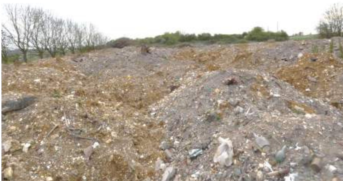
Figure 29 : Photographie n°10 de la zone Nord-Est du site. Ce secteur est utilisé de façon abusive pour entreposer des déchets inertes issus de travaux de démolition et de terrassement.
