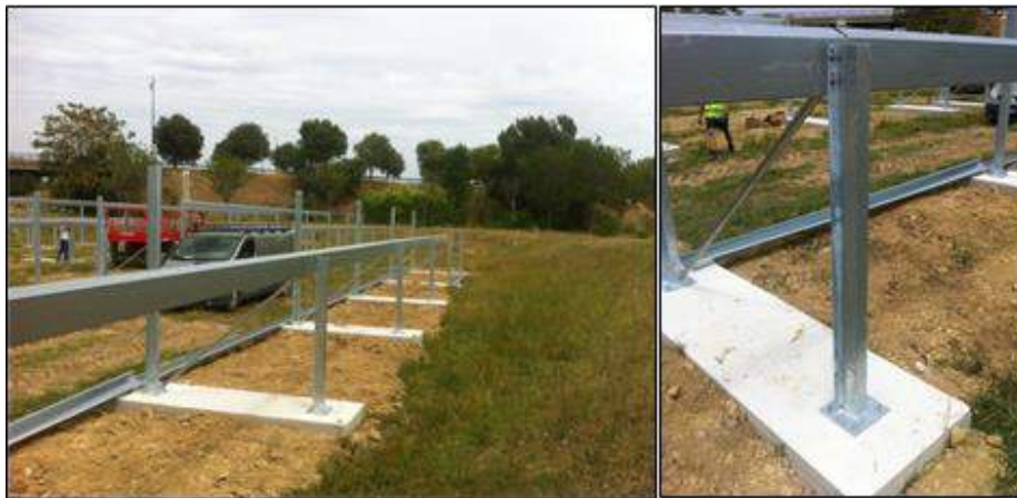
Figure 6 : Longrines en béton.
