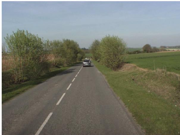
Sur ce secteur, la création de zones de sécurité (accotements de 4 mètres) implique la suppression des arbustes. En contrepartie, la reprise des talus prévoit un angle de talutage plus faible permettant la mise en place d'une couche de terre végétaleensemencée d'un mélange adapté, et sur laquelle le développement d'une nouvelle végétation ligneuse sera obtenu soit par plantation d'espèces ligneuses champêtres, soit colonisation spontanée favorisée par le fauchage tri annuel des talus.
