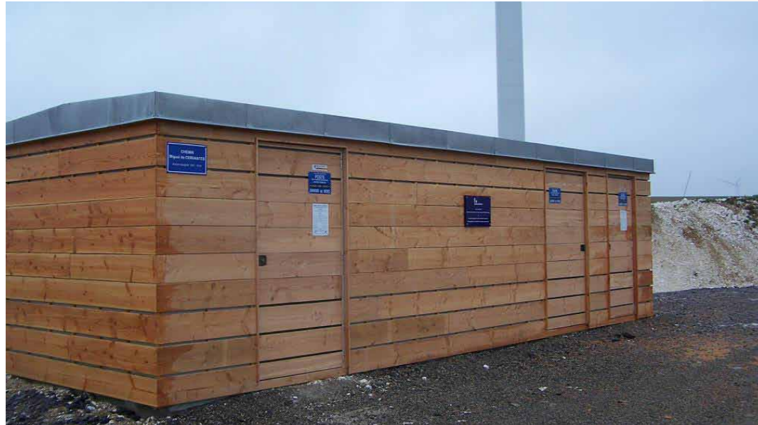
Exemple de poste de livraison avec bardage bois
