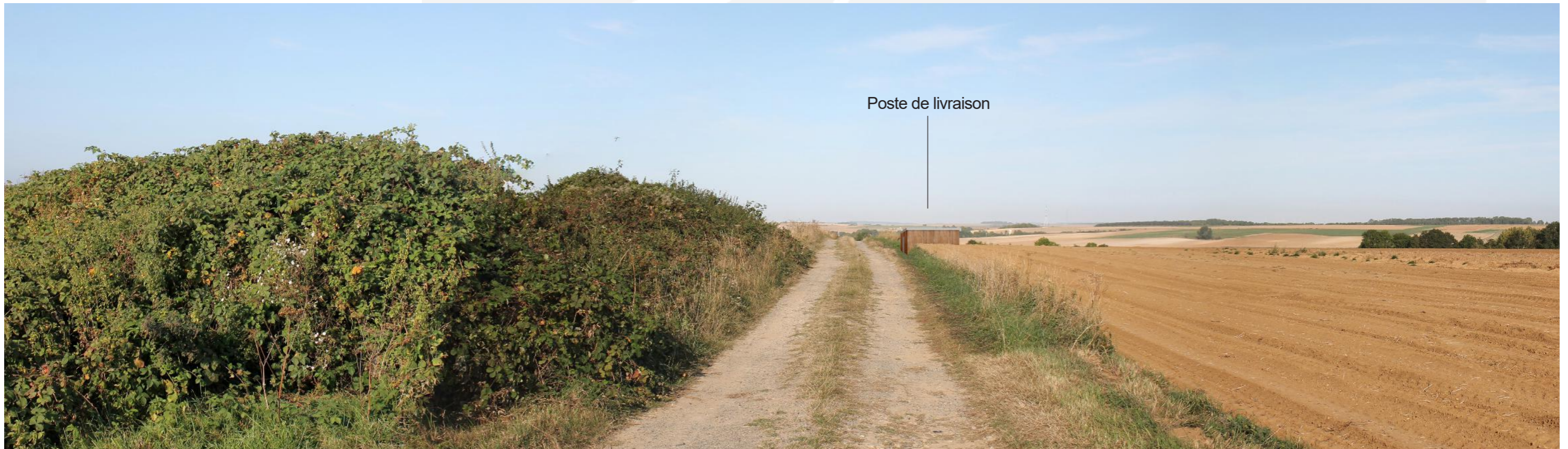
Le poste de livraison est localisé à près de 200 mètres de la départementale 6. La couleur du bardage permet une bonne intégration dans le paysage champêtre.
