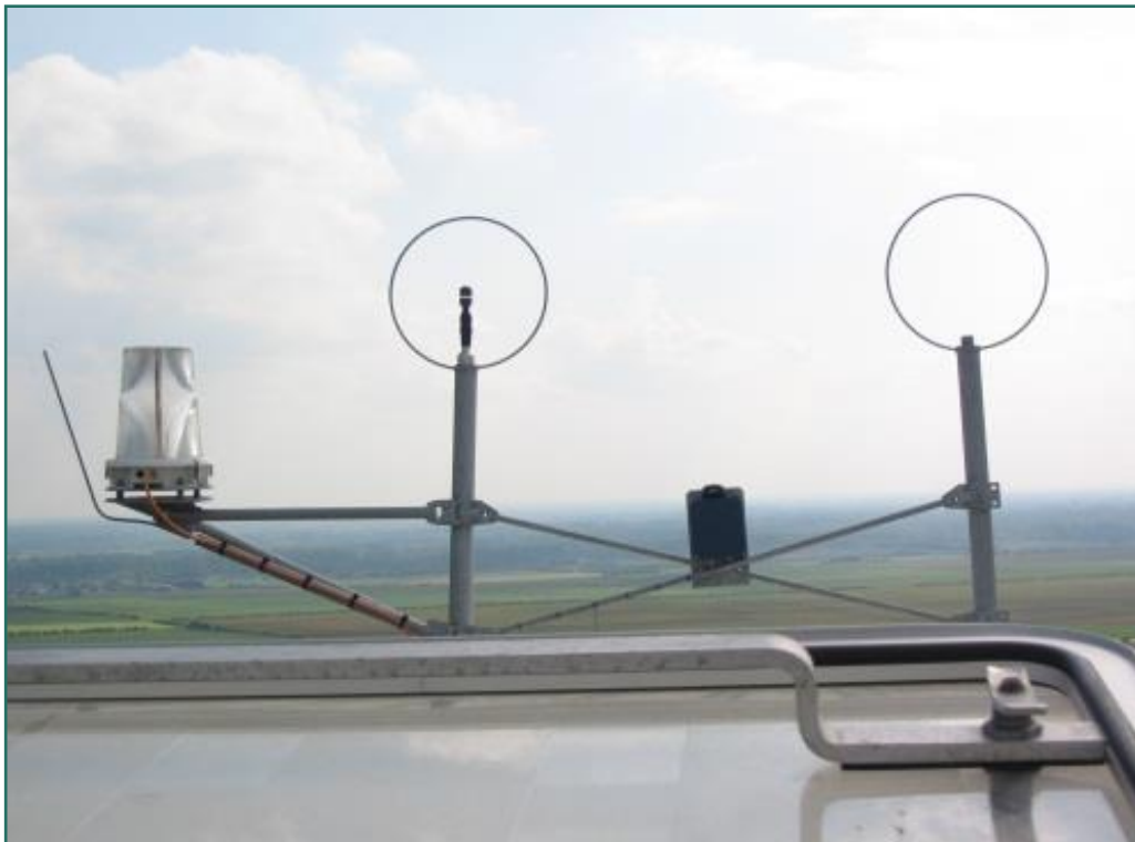
Figure 11 : Photographie d'un exemple de balisage aéronautique
