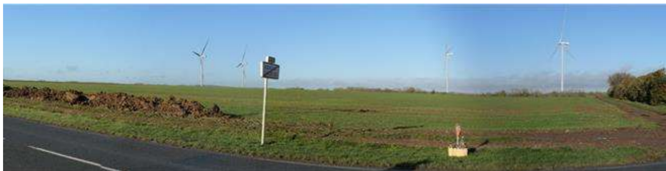
Photomontage du parc éolien des Moulins du Monchel - Réalisé depuis la sortie Sud-Ouest d'Ayencourt-Le-Monchel
