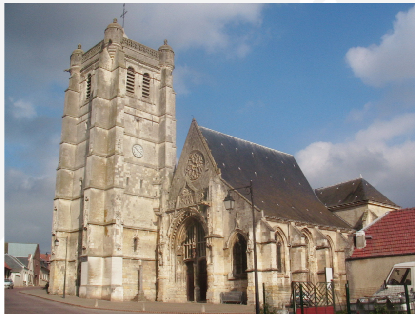
60 - Caix - église - MH classé
