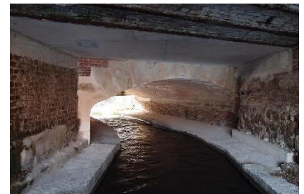
Pont en partie restauré
