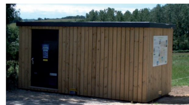
PRINCIPE DE BARDAGE BOIS JOINTIF
