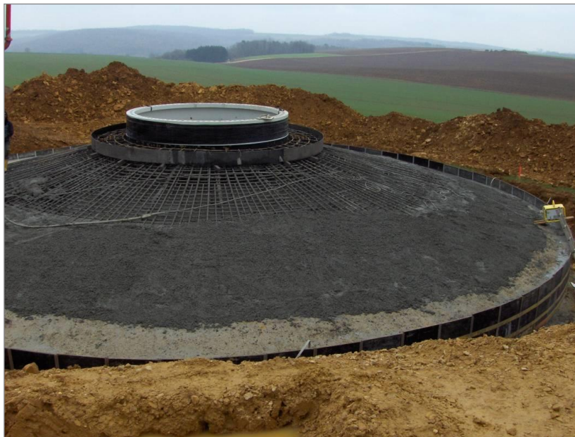
Figure 14 : Exemple de ferrailage en radier pour une éolienne (chantier en cours, source Vestas)
