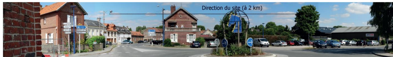
Figure 70 : Vue partiellement ouverte vers l'est depuis la RD 920 dans l'est du bourg de Conty dans le fond de vallée
