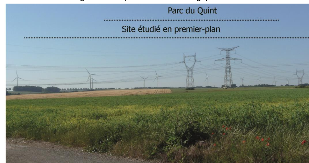
Figure 59 : Ligne haute-tension dans la partie est du site - Vue depuis l'est du Bosquel
