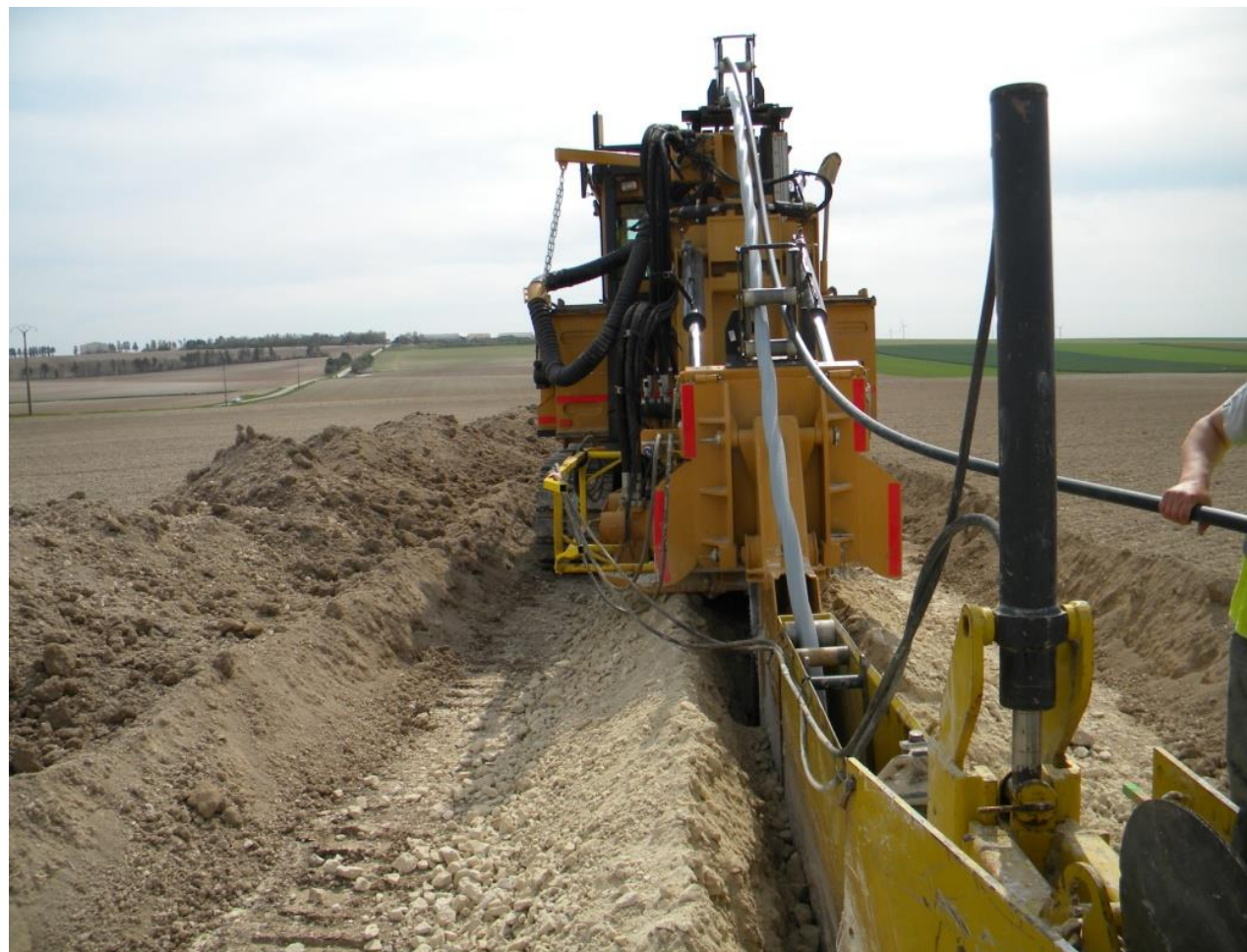
Tranchée pour le passage des câbles électriques
