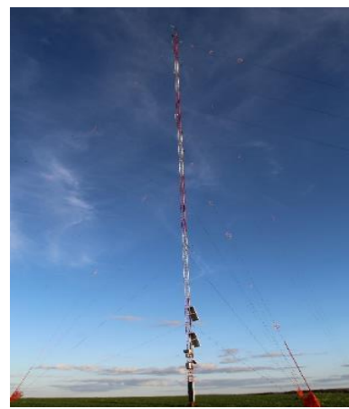
Exemple de mât de mesure
