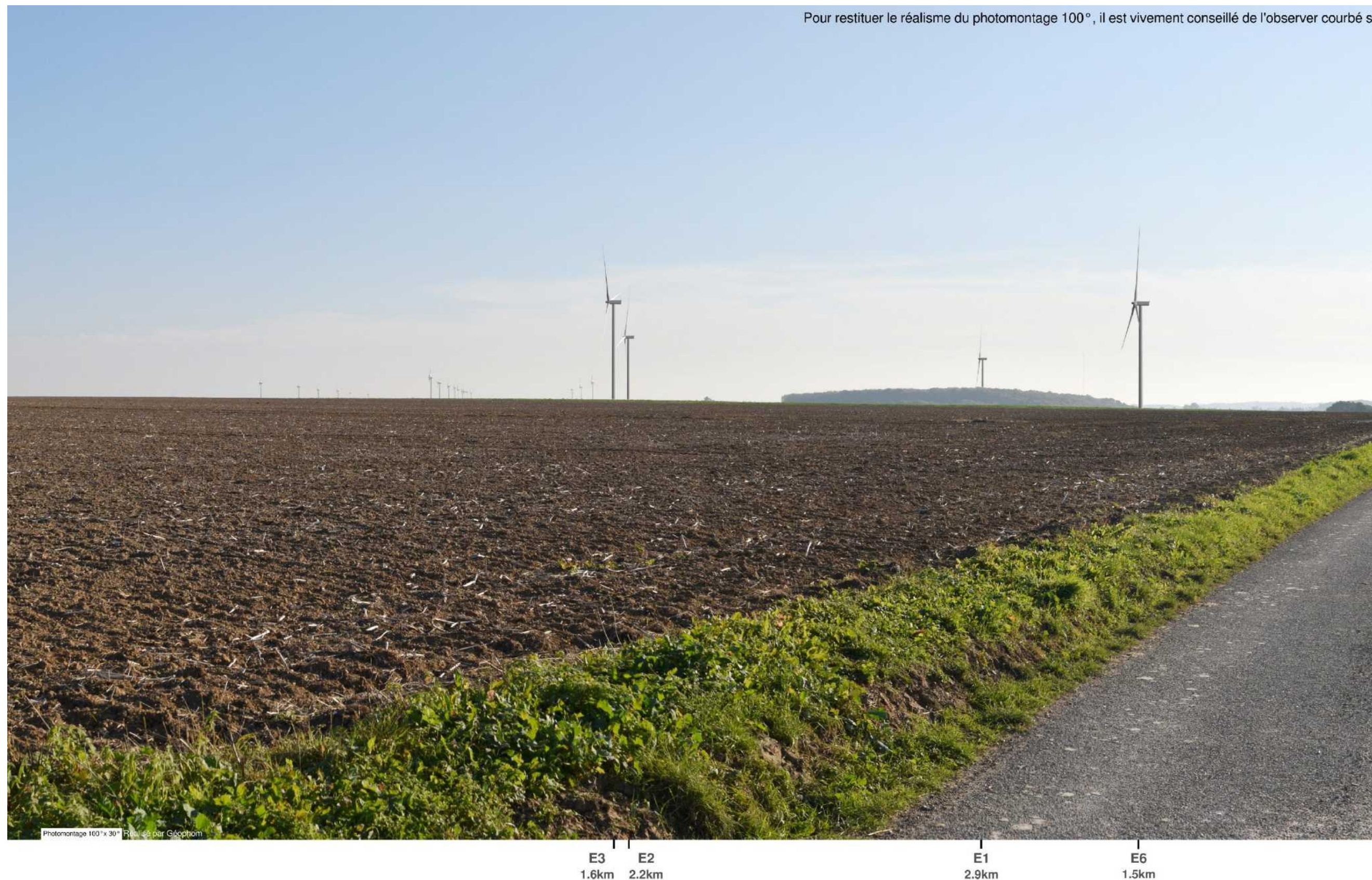
Figure 186 : Photomontage n°23 depuis la sortie Sud-Ouest de Fontaine-le-Sec - Partie 2/3 (source : ATER Environnement, 2020)
