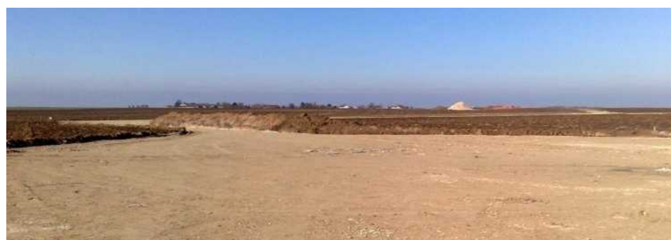
Figure 144 : Exemple d'aire de montage, grave compactée sur géotextile
