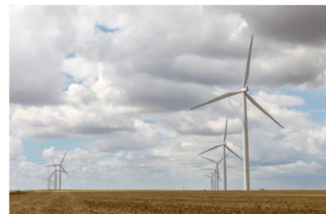
Photographie 12. Les parc éolien du Val de Noye 1 & 2
