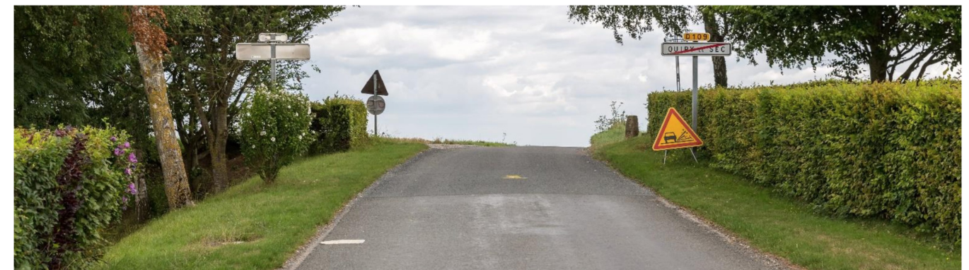
La chaussée montante à la sortie de Quiry-le-Sec face à la salle communale
