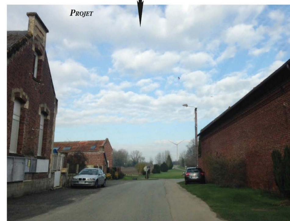
Figure 140 : Simulation de l'enfouissement du réseau sur la commune d'Assainvillers 1/2 (source : Laurent COUASNON, 2016)
