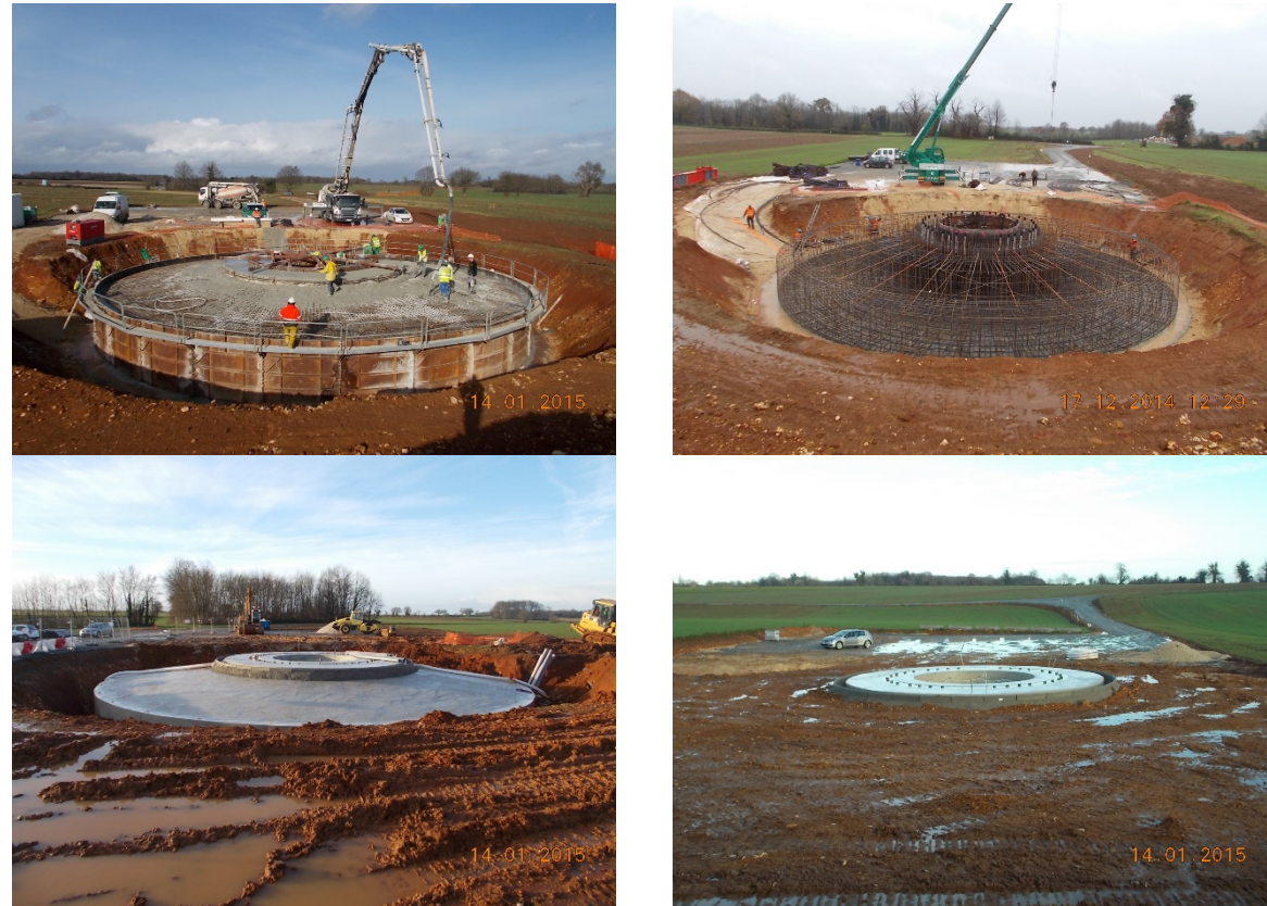
Figure 96 : Mise en place des fondations (source : Enercon, 2016)
