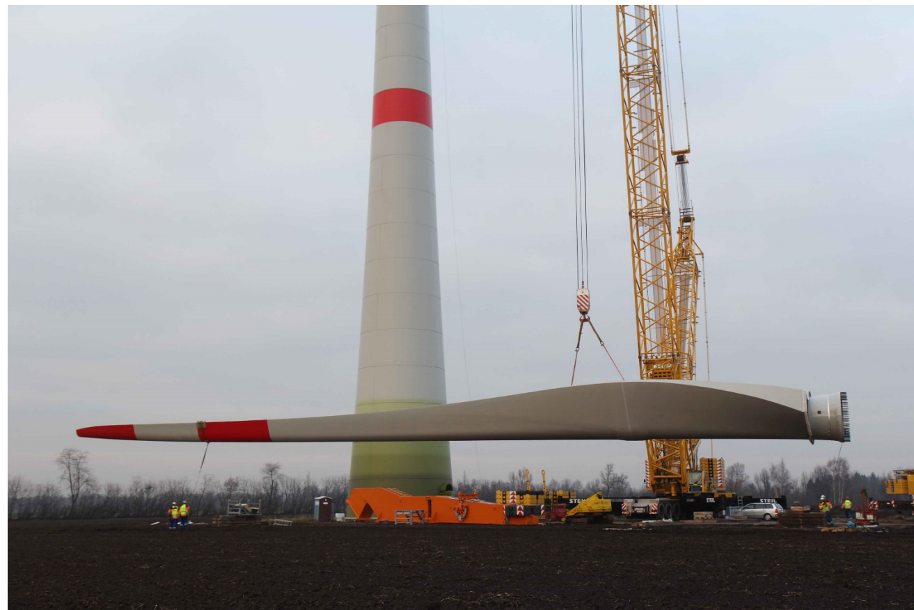
Figure 101 : Illustration d'un chantier (source : Enercon, 2016)
