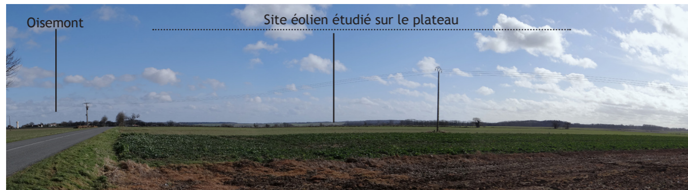
Fig.41. Vue sur le site éolien depuis le Nord Ouest depuis la RD936 à l'Ouest de Oisemont.
