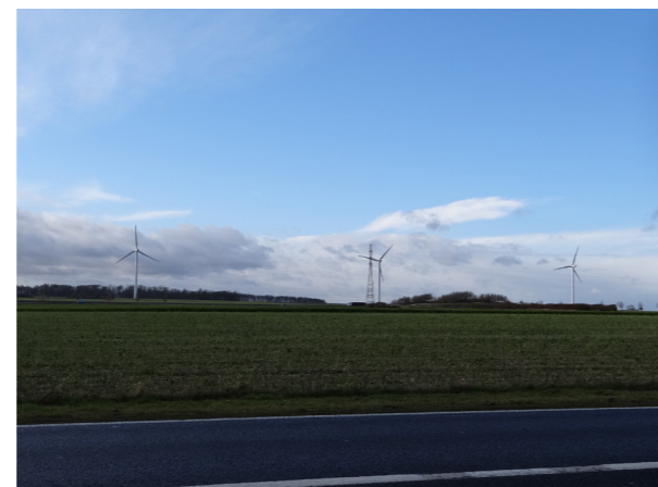
Fig.25. Vue vers le Sud depuis la RD1001. Autoroute A16 et parc éolien
