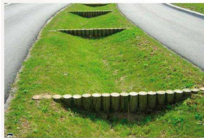
Noue d'infiltration avec cloisons
