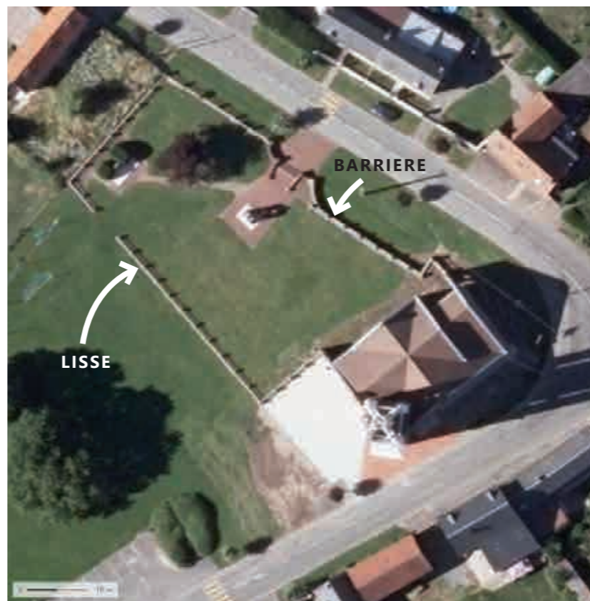
Vue aérienne de l'existant - Geoportail
