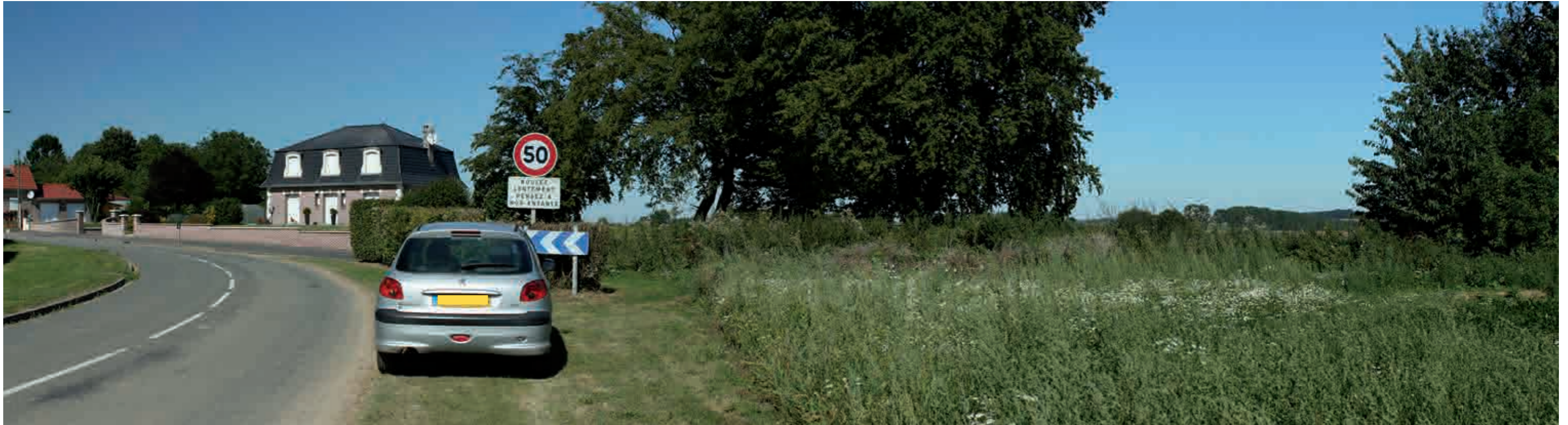
VUE DE L'EXISTANT 42a
