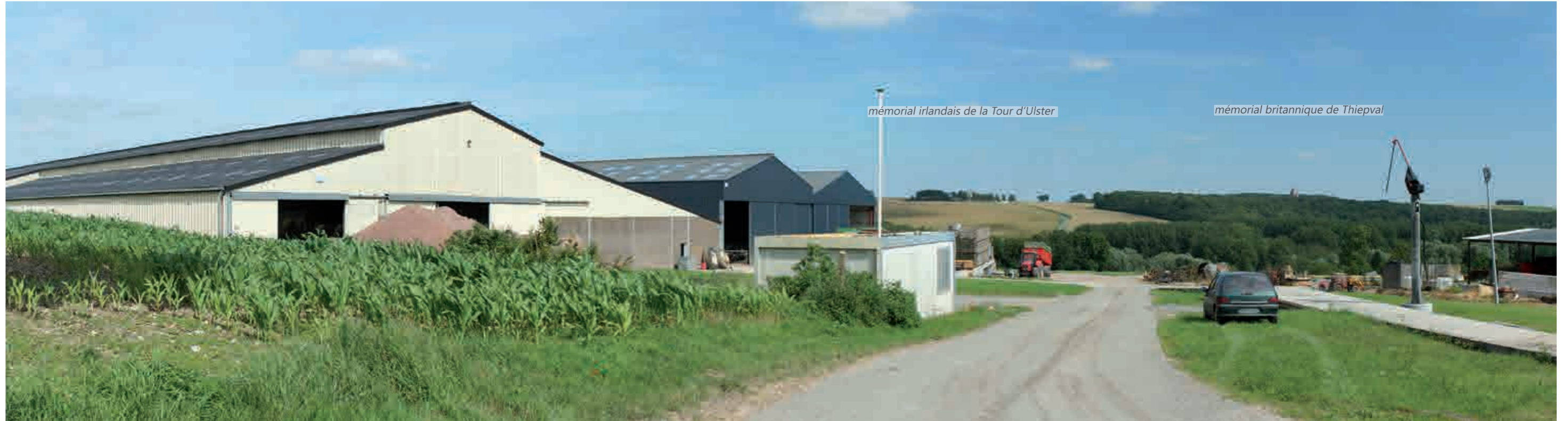
VUE DE L'EXISTANT 69a
