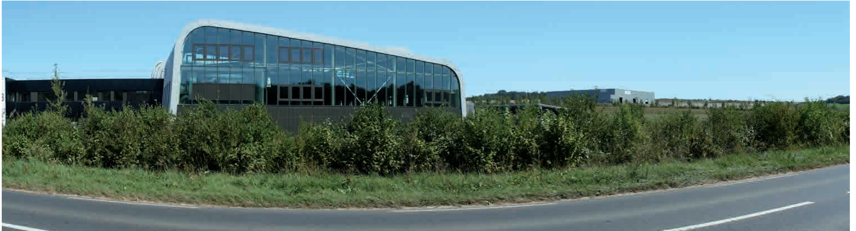
VUE DE L'EXISTANT 77a
