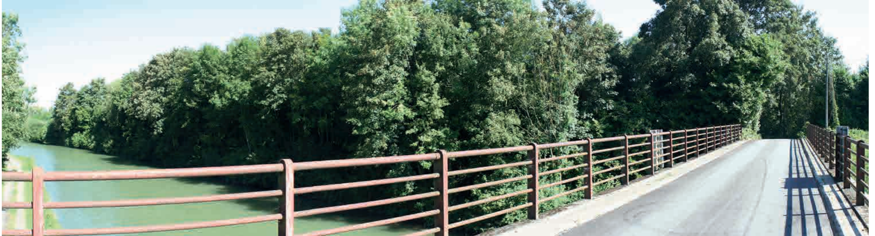
VUE DE L'EXISTANT 107a
