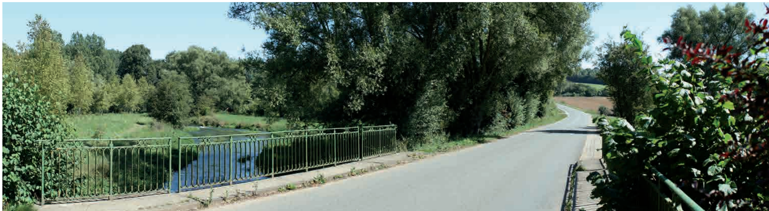
VUE DE L'EXISTANT 70a
