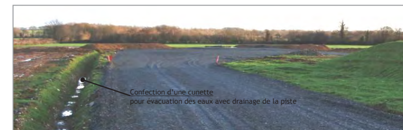
Figure 7 : exemple cunette réalisée en bordure de voirie
