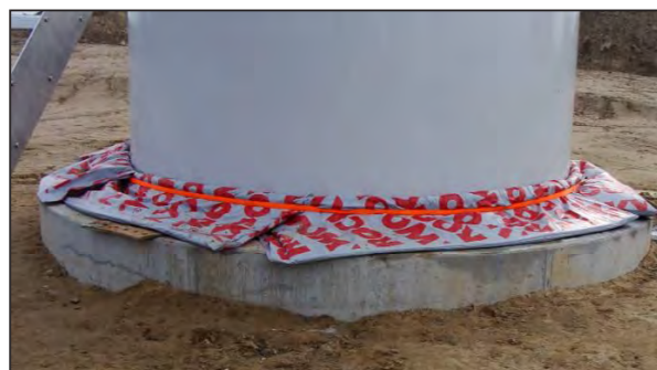
Figure 25 : Protection après Sealing de l'Anchor Cage
