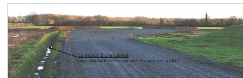
Figure 7 : exemple cunette réalisée en bordure de voirie
