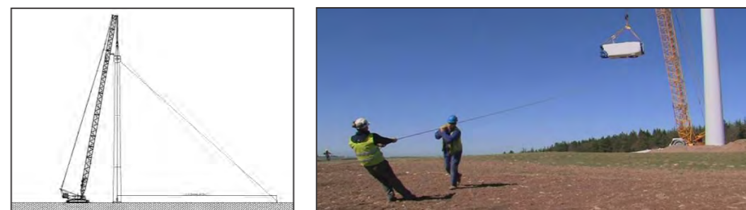
Figures 45 : Schéma levage nacelle / Exemple opération de levage d'une nacelle avec orientation au sol
