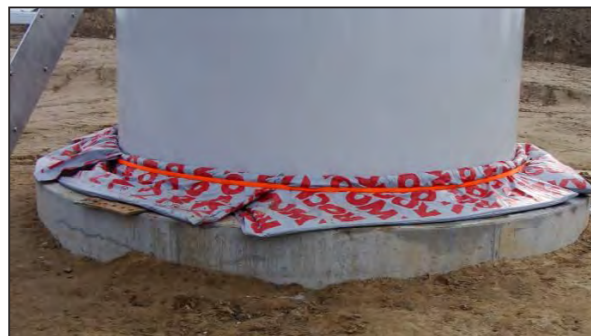
Figure 25 : Protection après Sealing de l'Anchor Cage
