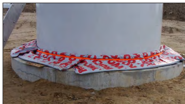
Figure 25 : Protection après Sealing de l'Anchor Cage
