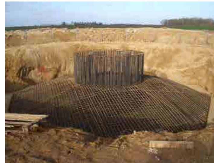
Photographie 13 : Armature d'acier de la fondation
