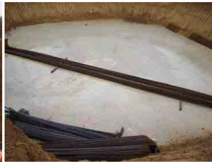
Photographie 10 : Béton de propreté avant le montage de l'armature de ferraille
