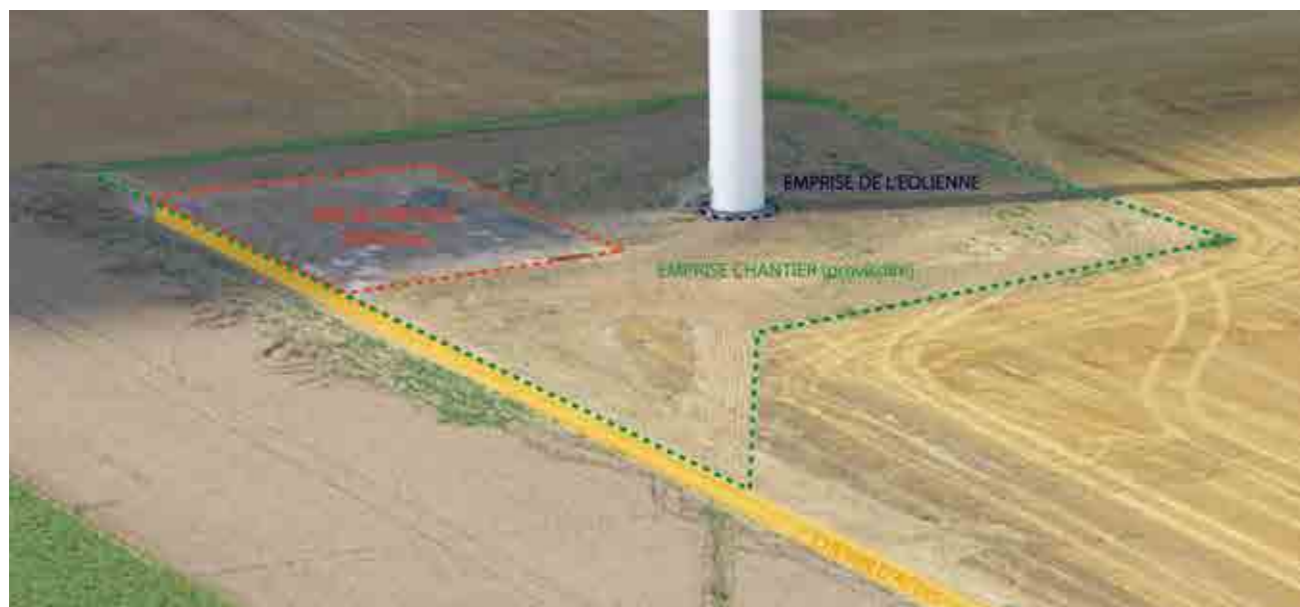
Photographie 5 : Vue sur les aires aménagées autour d'une éolienne
