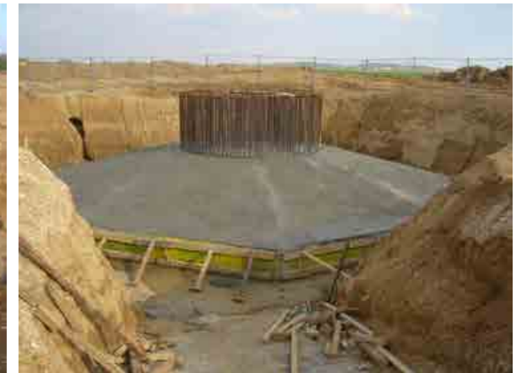
Photographie 16 : Coulage de béton sur l'armature
