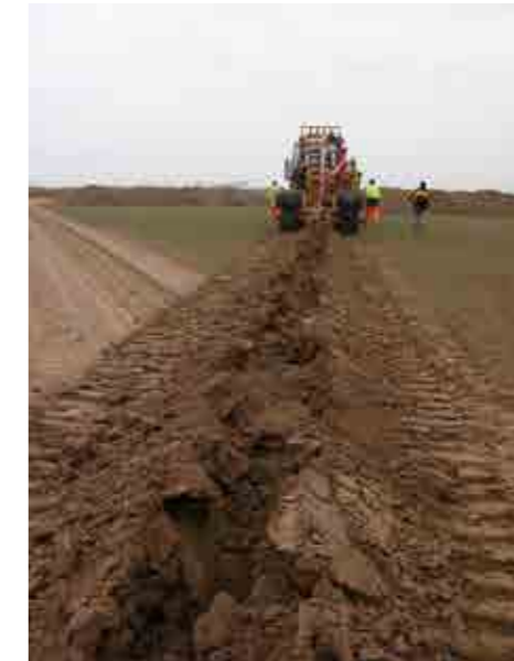
Photographie 2 : Pose des câbles avec un soc vibrant, limitant les dégâts dans les champs
