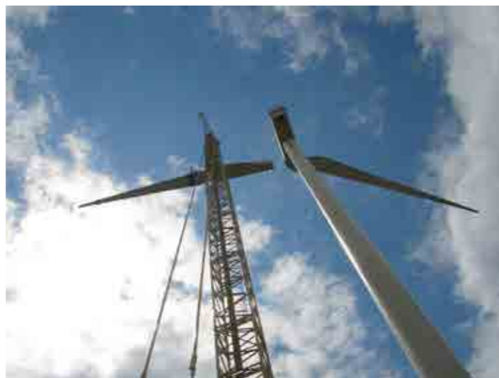
Photographie 21 : Assemblage d'une pale
