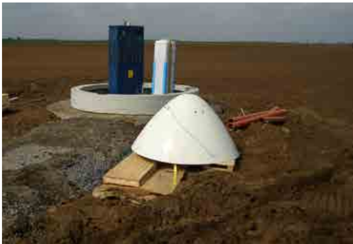
Photographie 8 : Virole (embase) de l'éolienne, stockée sur une aire stabilisée
