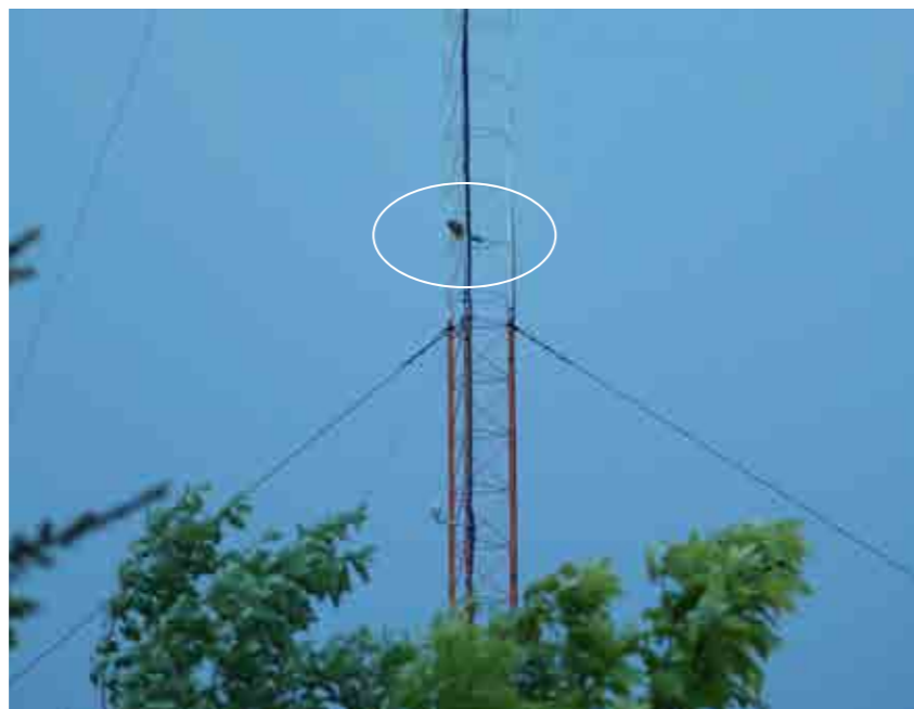
Photographie 65 : Exemple d'un mât de mesure de vent et de ses effets sur l'avifaune
