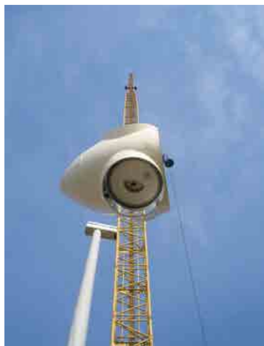
Photographie 19 : Levage du moyeu en fonte
