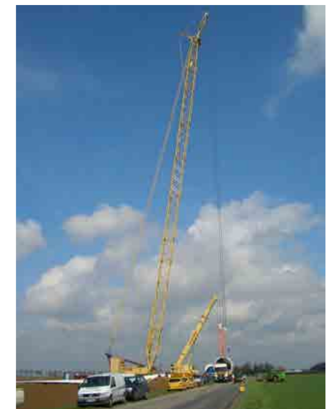
Photographie 17 : Levage d'une section de mât par la grue principale assistée de la grue auxiliaire 1
