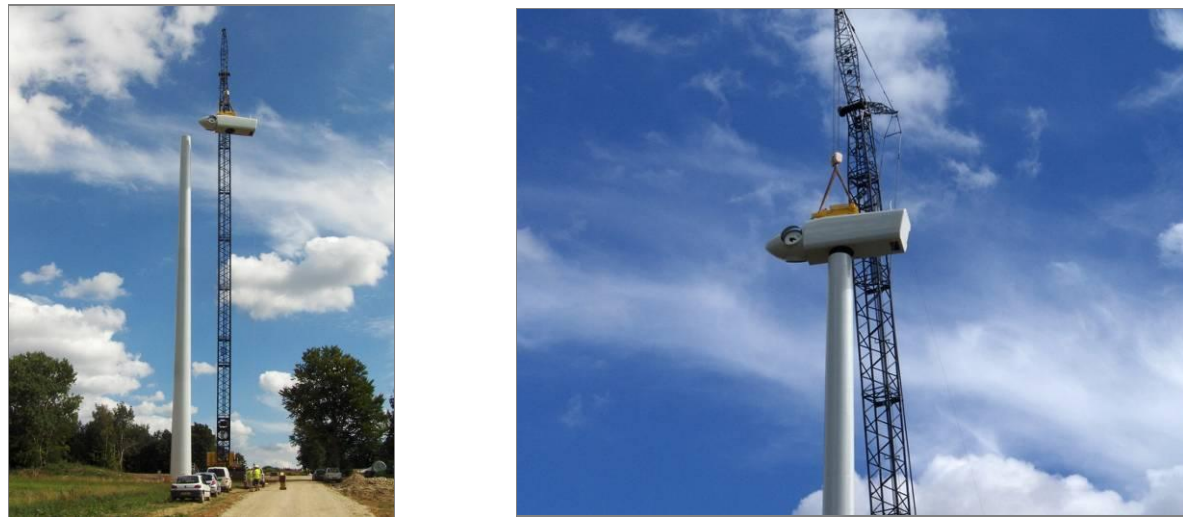
Figure 19 : photos du chantier - assemblage de la nacelle
