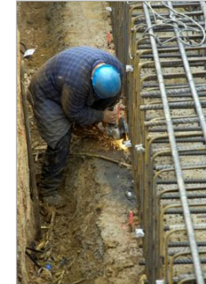
Préparation des fondations
