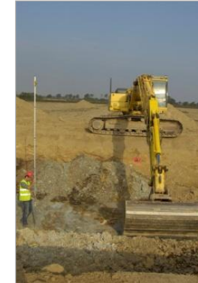
Fouille de la fondation
