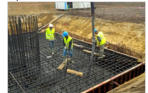
Coulage du béton
