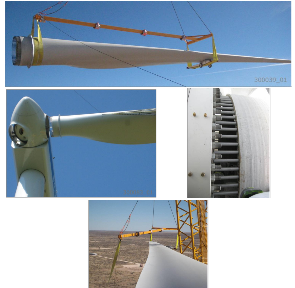
Figure 20 : photos du chantier - assemblage des pales
