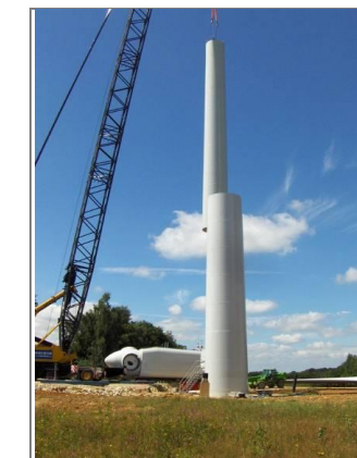
Figure 18 : photos du chantier - assemblage de la tour
