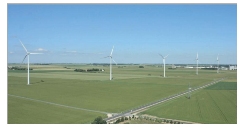
Figure 4 : Parc éolien de Pithiviers (45) 5 x 2MW (Source – Idex)
