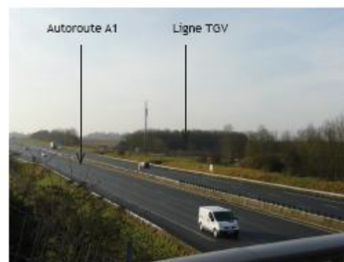
Figure 47 : Autoroute A1 doublée de la ligne TGV
