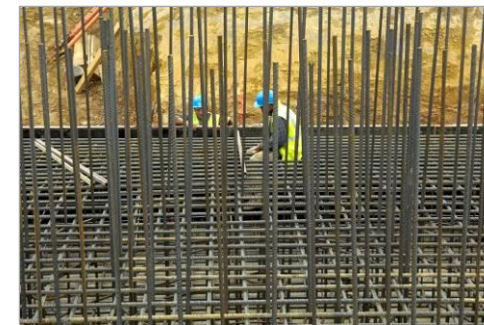
Ferraillage de la fondation
