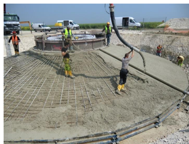
Photographie 2 : Coulage du béton
