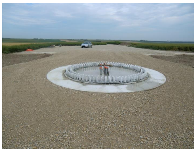
Photographie 4 : Fondation terminée
