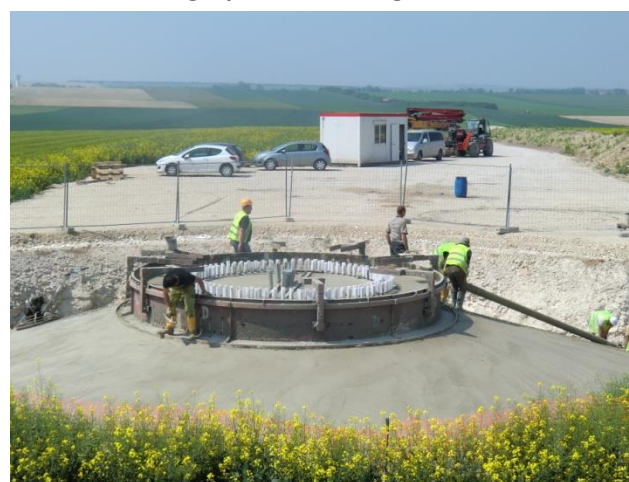
Photographie 3 : Béton terminé
