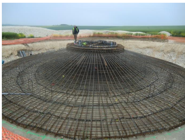
Photographie 1 : Excavation et préparation de l'armature
